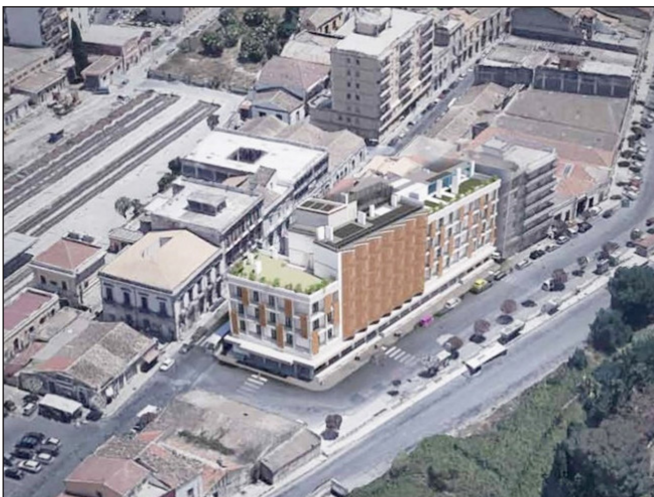
Intervento architettonico di rifunzionalizzazione
