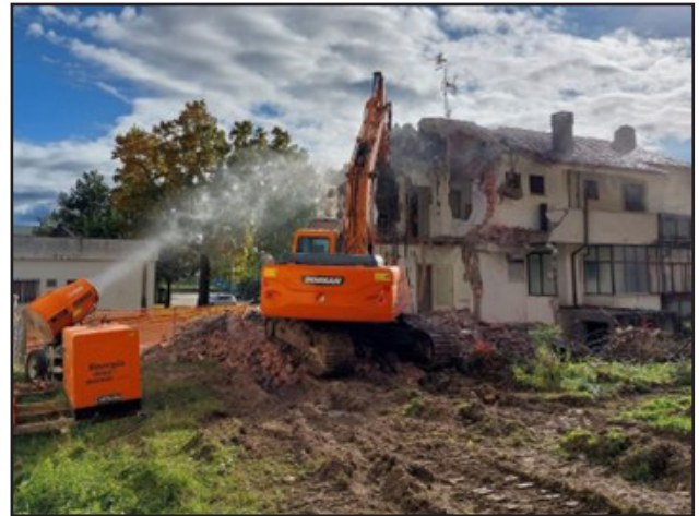
Lavorazioni in corso - Demolizione selettiva
