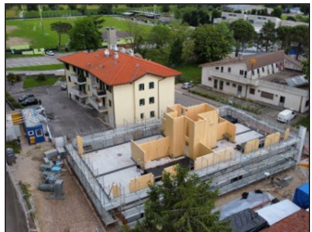
Lavorazioni in corso - Realizzazione elevazioni
