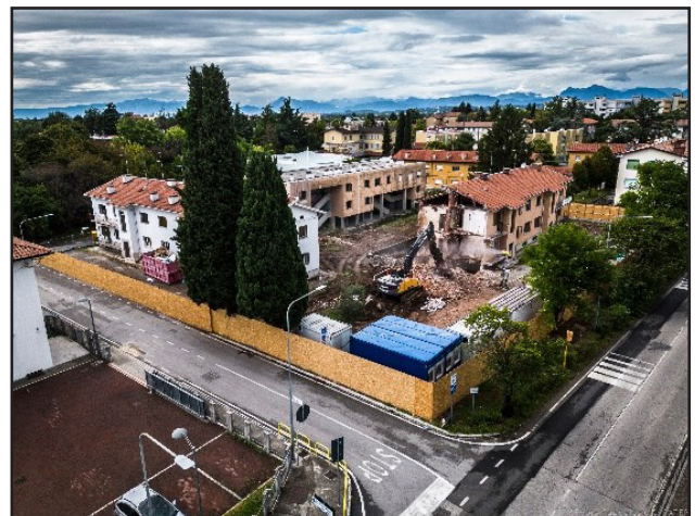
Lavorazioni in corso - Demolizione selettiva
