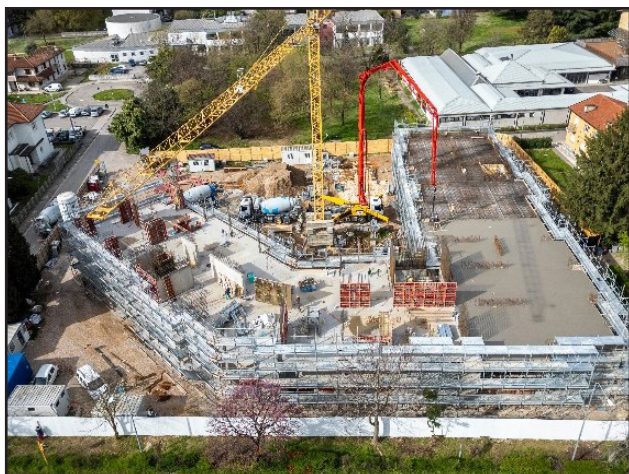
Lavorazioni in corso - Realizzazione elevazioni
