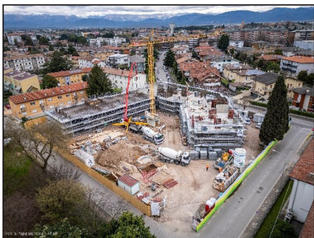
Lavorazioni in corso - Realizzazione elevazioni
