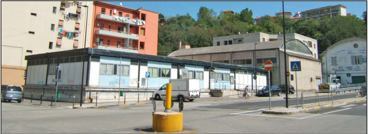
Complesso edilizio esistente
