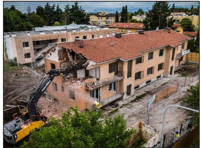
Lavorazioni in corso - Demolizione selettiva
